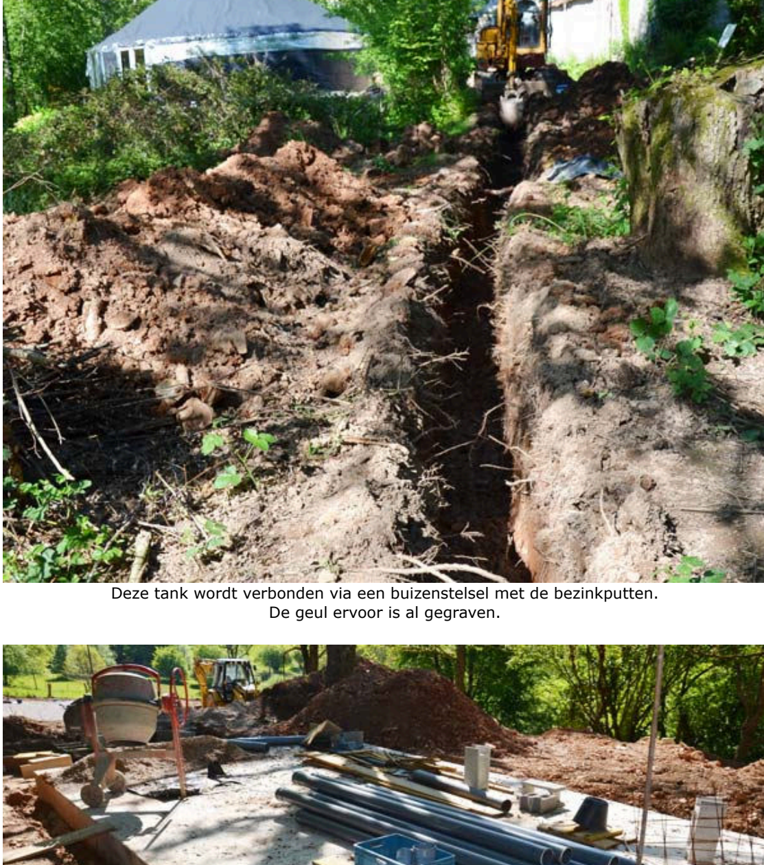
Deze tank wordt verbonden via een buizenstelsel met de bezinkputten. De geul ervoor is al gegraven.
