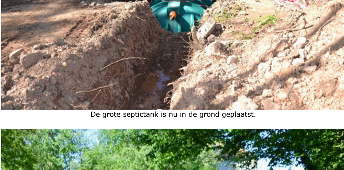
De grote septictank is nu in de grond geplaatst.
