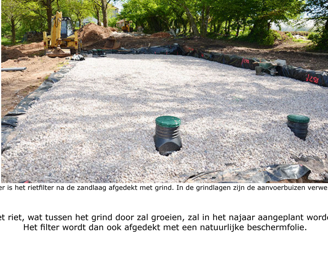
Hier is het rietfilter na de zandlaag afgedekt met grind. In de grindlagen zijn de aanvoerbuizen verwerkt.
