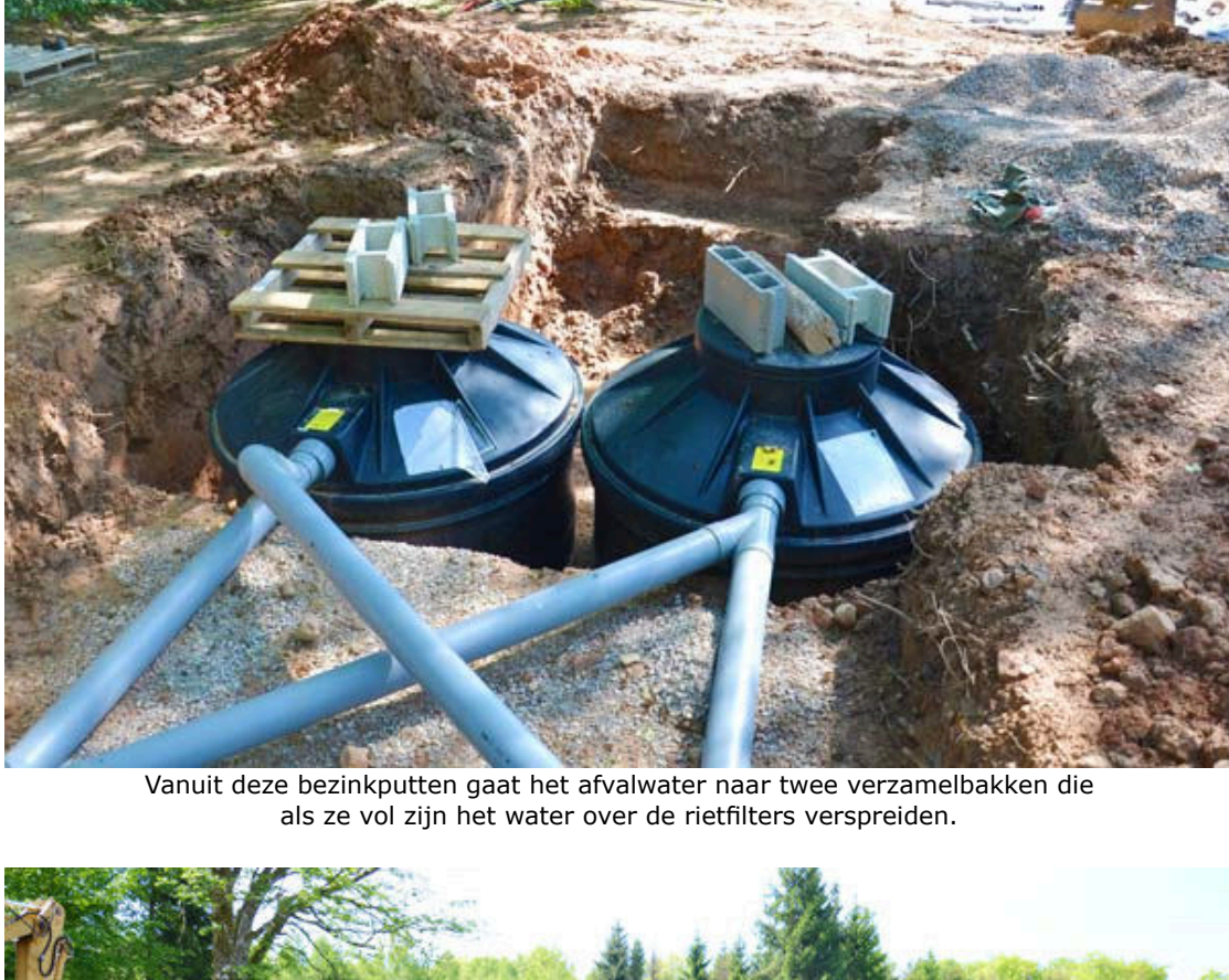
Vanuit deze bezinkputten gaat het afvalwater naar twee verzamelbakken die als ze vol zijn het water over de rietfilters verspreiden.
