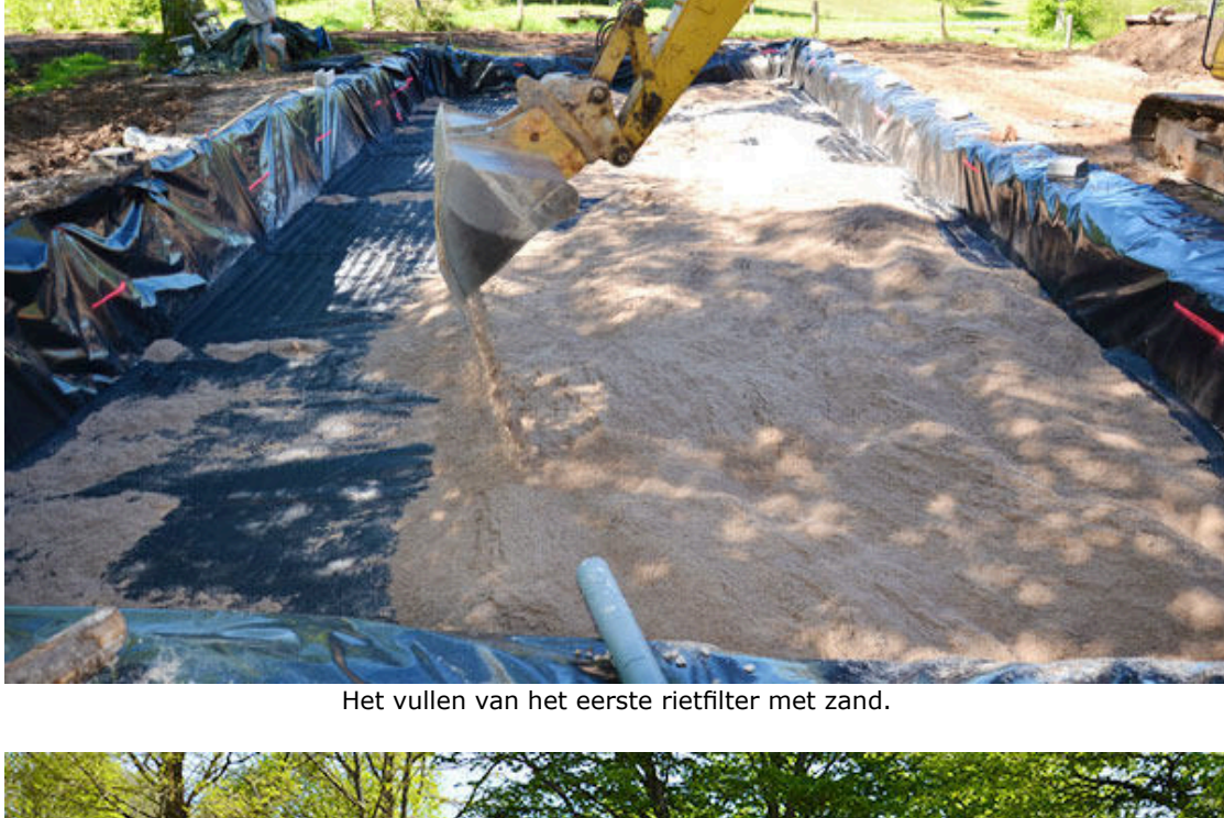
Het vullen van het eerste rietfilter met zand.
