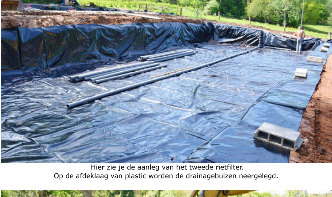
Hier zie je de aanleg van het tweede rietfilter. Op de afdeklaag van plastic worden de drainagebuizen neergelegd.
