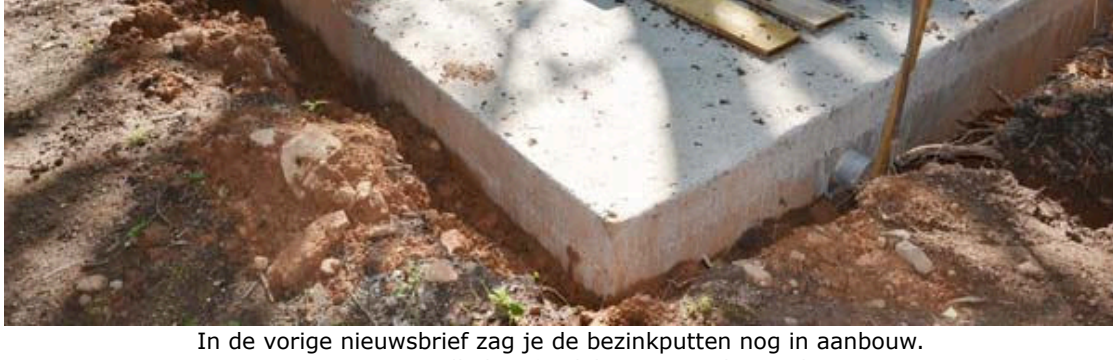
In de vorige nieuwsbrief zag je de bezinkputten nog in aanbouw. Hier zie je ze volledig afgedekt met een betonplaat.
