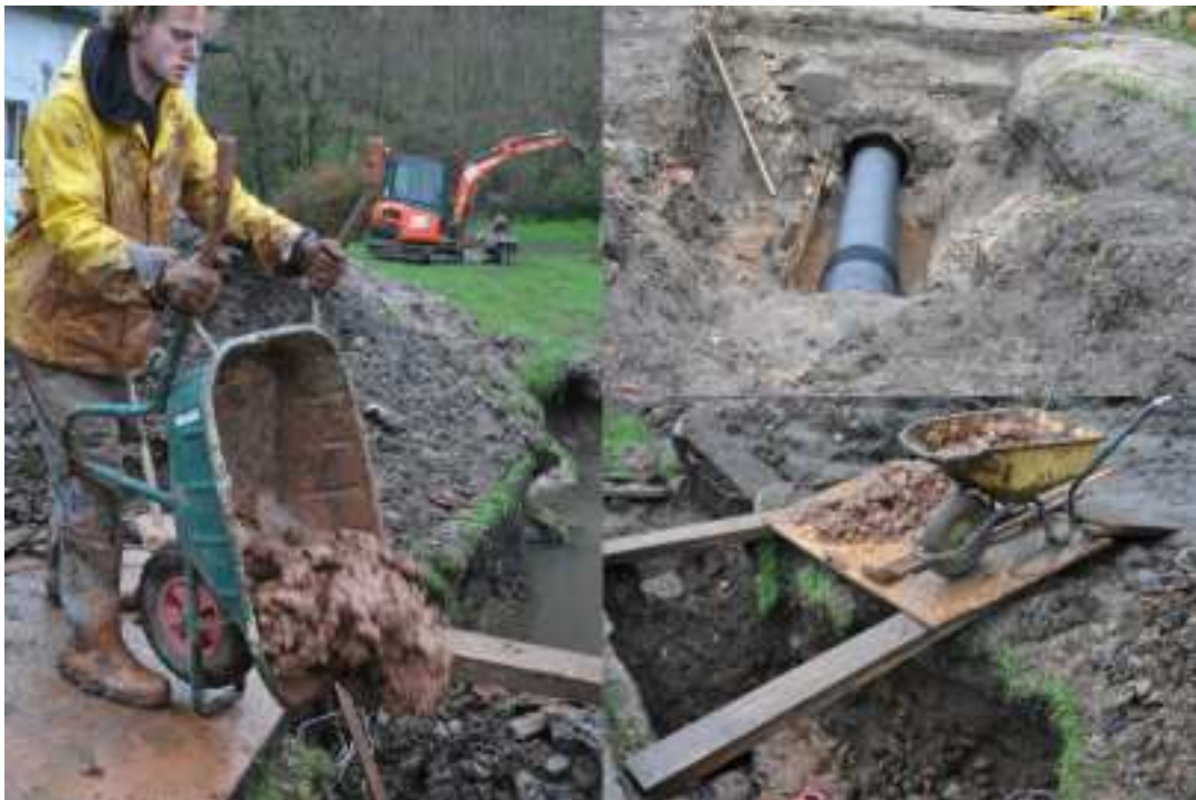
Versteving kadewand Forge Neuve
